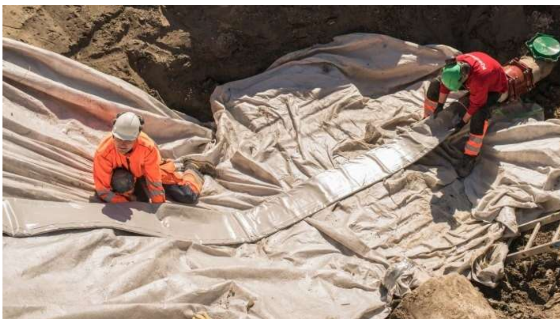
Figur 4. Installation Saertex-Liner H2O, Sande Kommun i Norge (SSTT, 2016)
